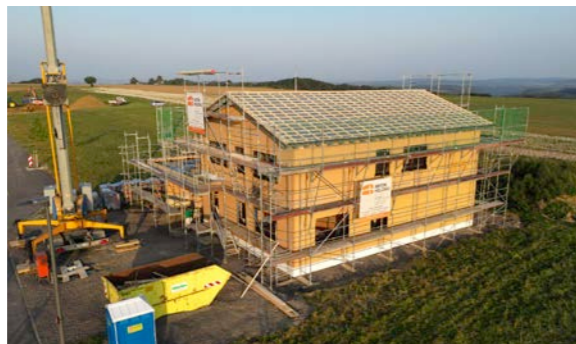
▲ 60-mm-Holzfaserdämmplatte außen, darauf die Lattung und Konterlattung und abschließend wird eine vorgehängte hinterlüftete Fassade (VHF) aus thermobehandelter Weißtanne
