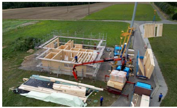
▲ Vorelementierung und kurze Bauzeit: Außenwände aus 180-mm-KVH-Balken
